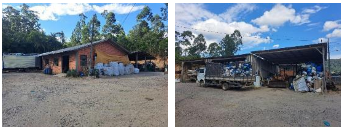
Figura 24 - Centro de Triagem de Vitor Meireles
