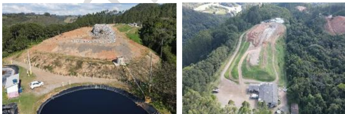
Figura 26 - Serrana Engenharia LTDA - Ibirama/SC
