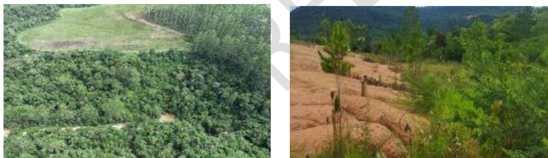
Figura 31 - Antigo depósito de lixo de Ituporanga e Jose Boiteux
